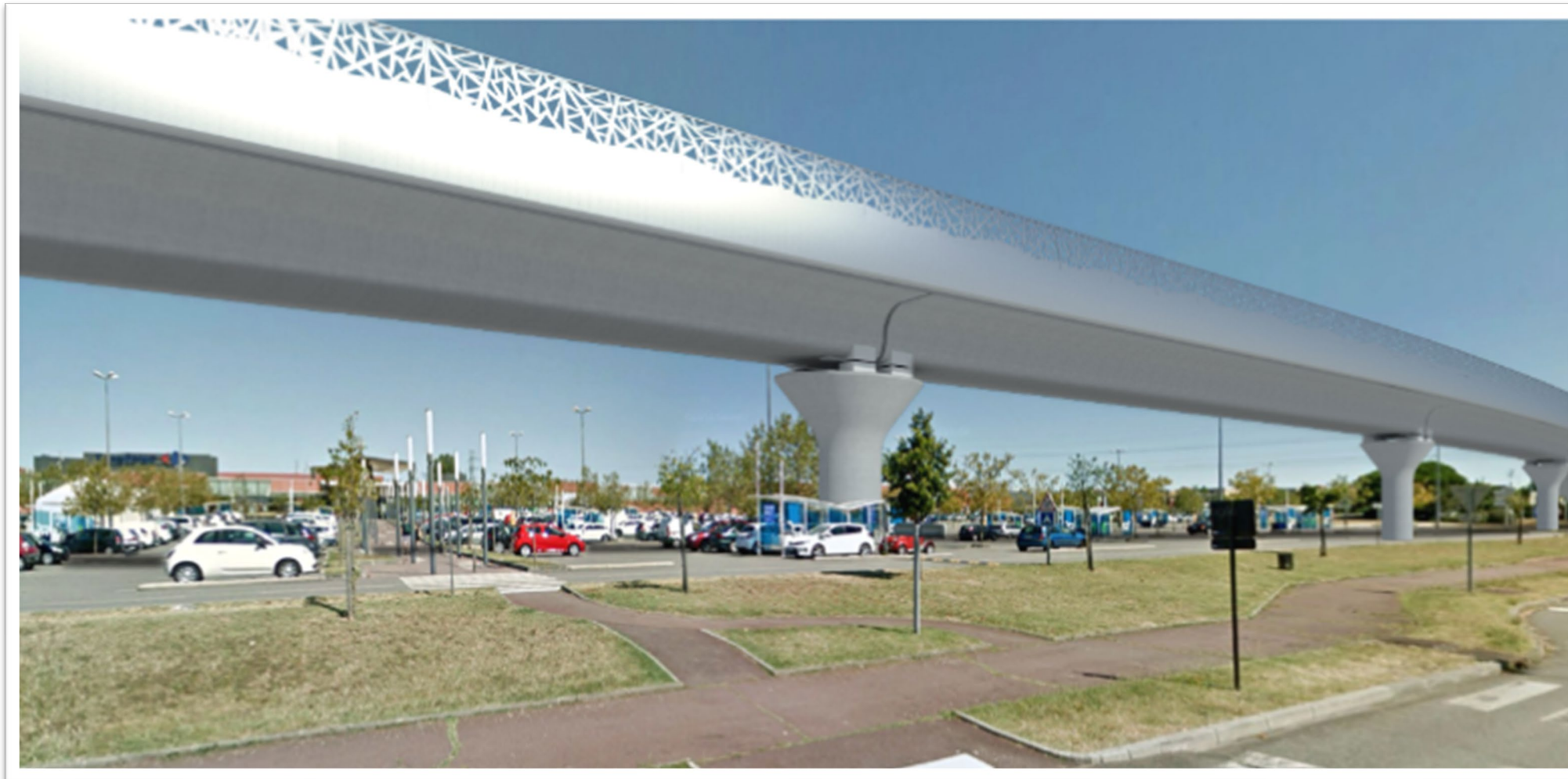
VIADUC 3 ème Ligne
