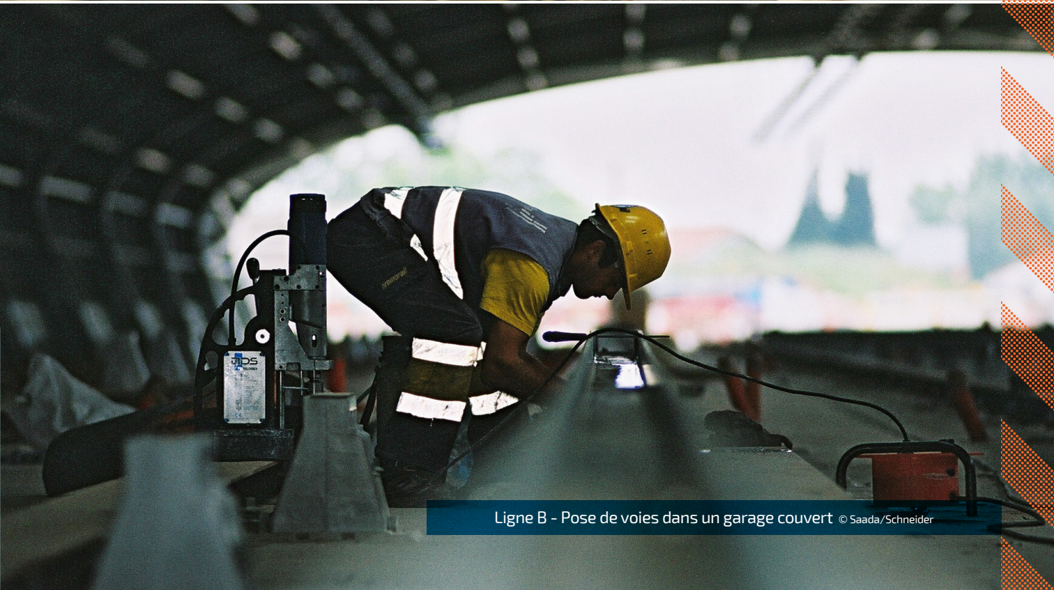
Ligne B - Pose de voies dans un tunnel cadre entre deux stations © Saada/Schneider
