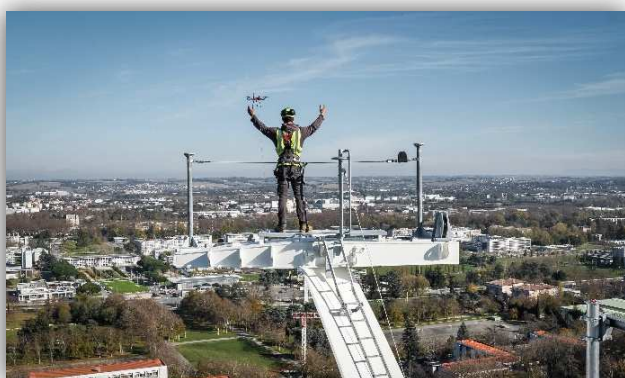
Novembre 2020 - Déroulage des câblettes par drone et hélicoptère
