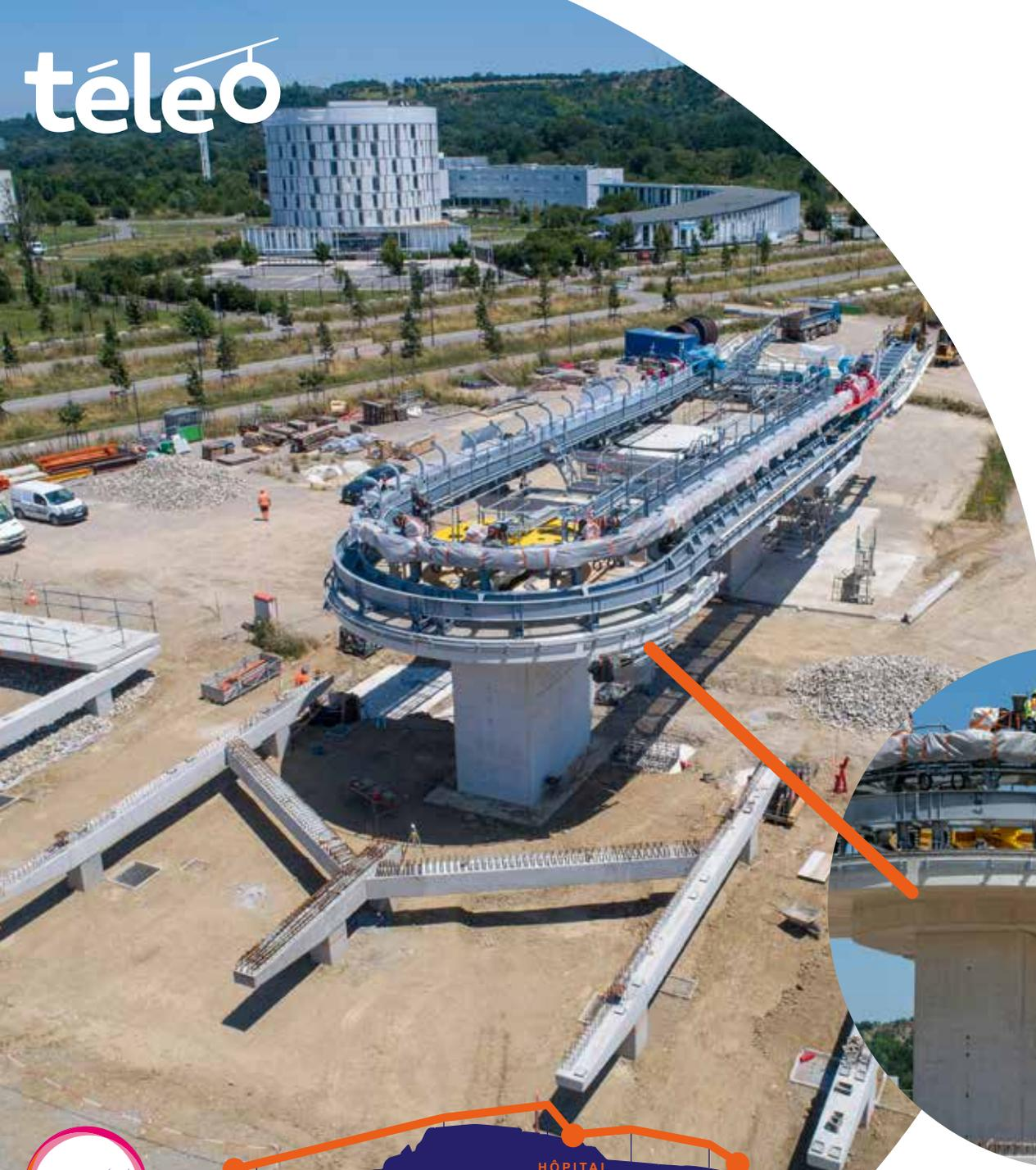
La station Oncopole est à ce jour la plus avancée des 3 : les poteaux support en béton sont terminés, ce qui a permis l'installation en son sommet des éléments du système permettant la mise en mouvement des cabines.
