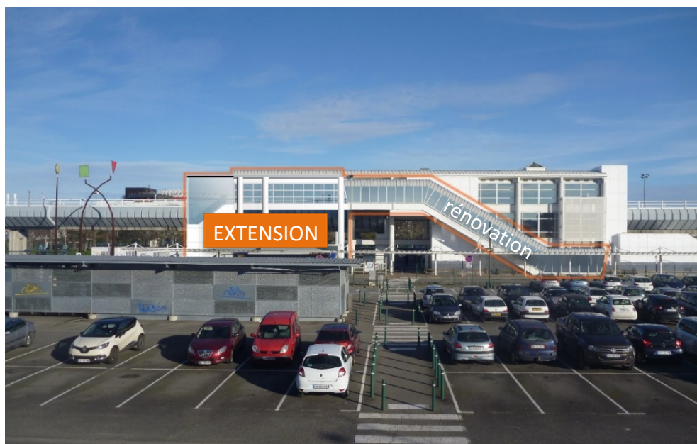
Station Basso Cambo après les travaux d'extension
